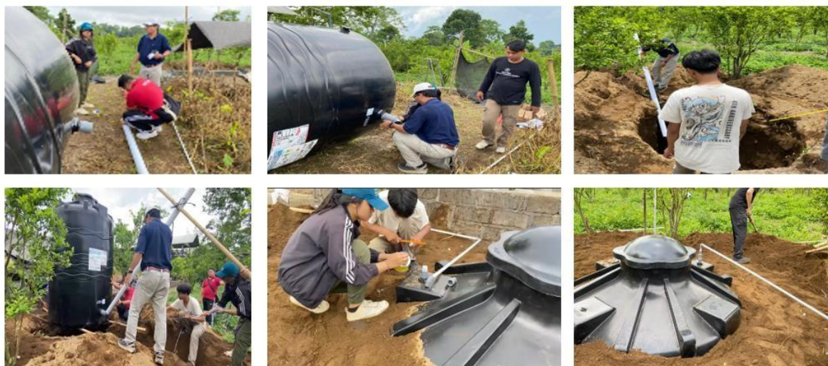
Gambar 7. Papanisasi biogas/biodigester (penulis, 2025)
