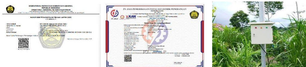
Gambar 2. Instalasi listrik 6.600 VA (penulis, 2025)
