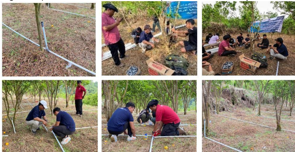
Gambar 4. Instalasi sprinkle tetes pada kebun jeruk (penulis, 2025)
