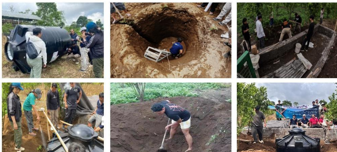
Gambar 6. Pemasangan biodigester (penulis, 2025)
