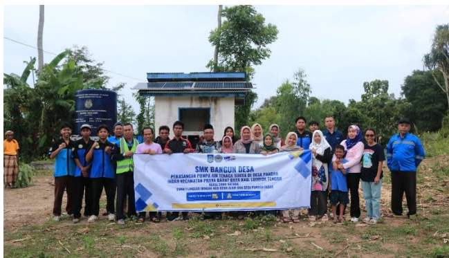
Gambar 1. Kegiatan Pemasangan dan Sosialisasi Pompa Air Tenaga Surya oleh Tim SMKN 1 Lingsar dan NGO Gema Alam NTB di Desa Pandan Indah ( Dokumentasi, April 2025 )
