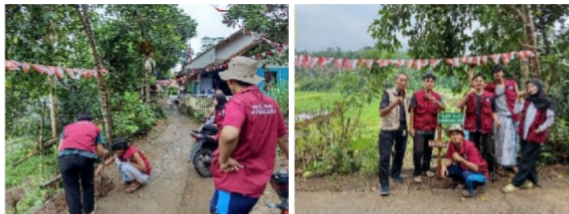
Gambar 4. Kegiatan Pemasangan Tanda Rawan Bencana Di Kp. Gunung Kilima
